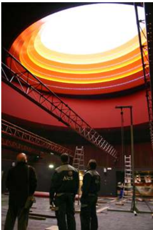
Vista interior de la cúpula. 2005.
