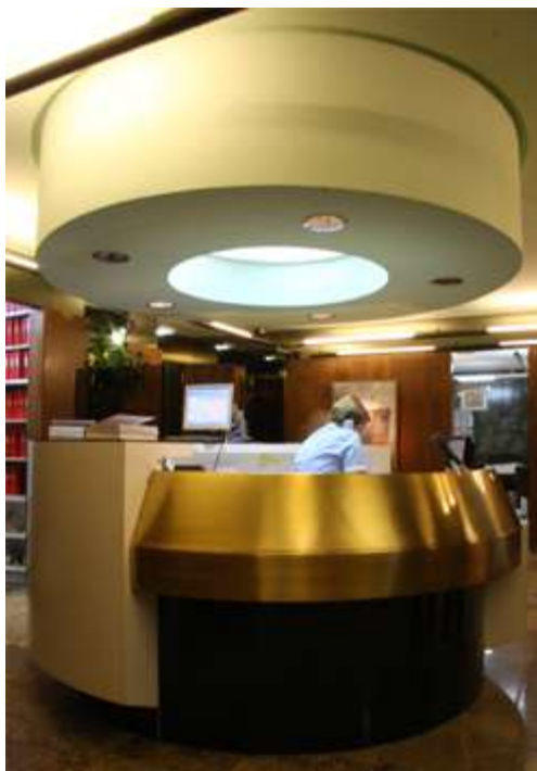
Detalle del frontal del mostrador en bronce dorado, cons-truido en dos únicas piezas que se ensamblan de manera cuidadosa para crear una superficie sin defectos de montaje o soldadura.
