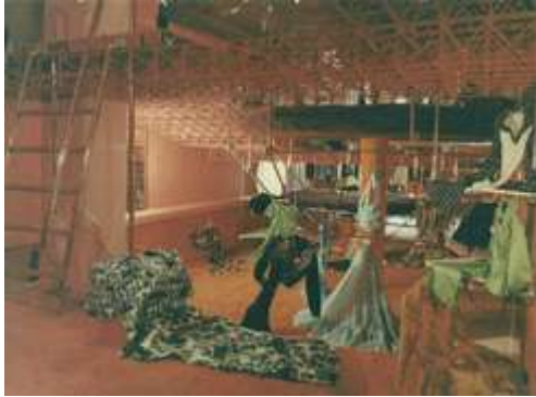
Planta inferior con estructura espacial de nudos y barras y la escalera de barco para el acceso.
