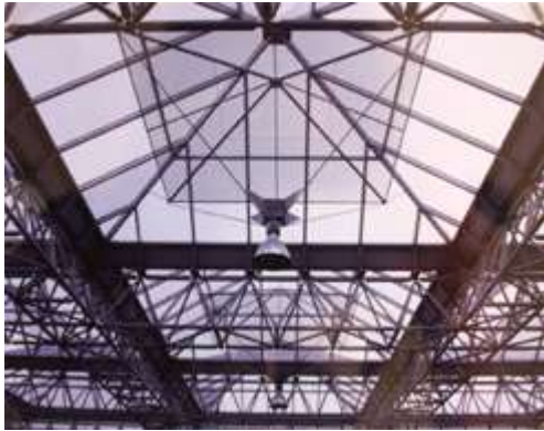
Detalle estructura cubierta del Centro Comercial.
