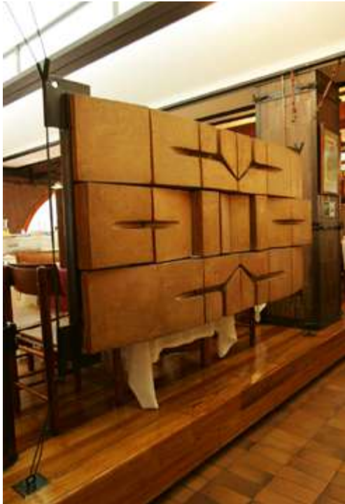
Uno de los paneles cerámicos realizados por Fernando Alba. 1974. Obsérvese cómo se disponen en suspensión.
